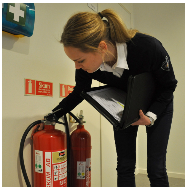
Kontroll av brandskyddet.
