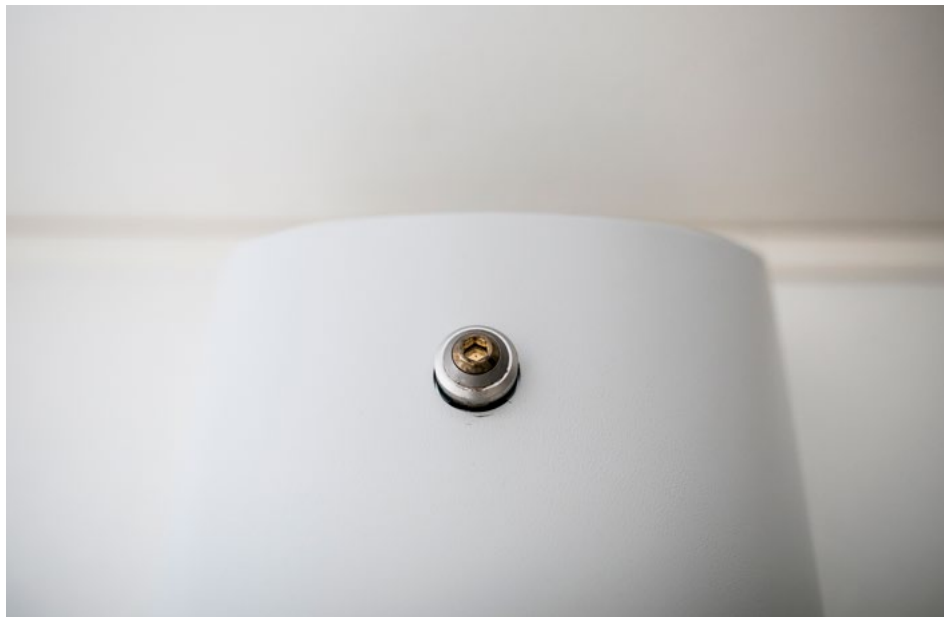
Munstycke som släcker med vattendimma i ett detektoraktiverat släcksystem. Foto: Pavel Koubek.
