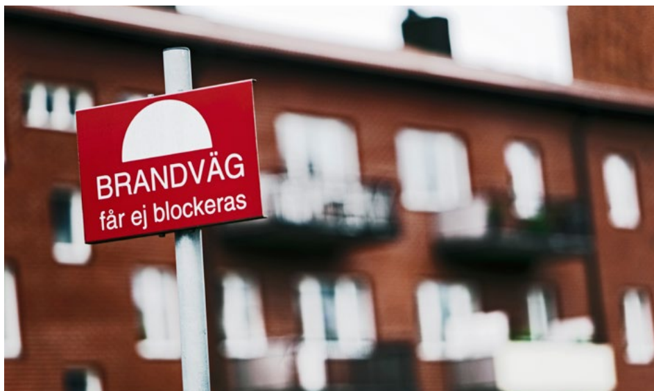
LSO ställer krav på brandskyddet i byggnader. Foto: Johan Eklund.
